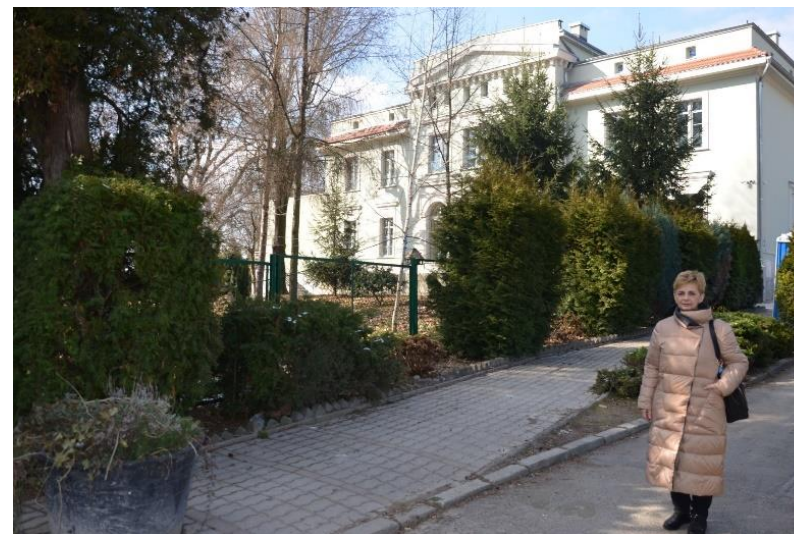
Fot. 8 - Wyremontowany budynek Publicznego Przedszkola nr 3 w Strzegomiu
