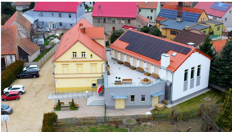
Fot. 7 - Nowa sala sportowa w Olszanach
