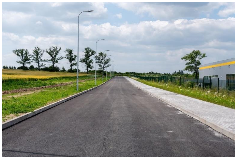
Fot. 1 - Ulica Piekarnicza: skomunikowanie z drogą krajową nr 5 terenów aktywności gospodarczej
