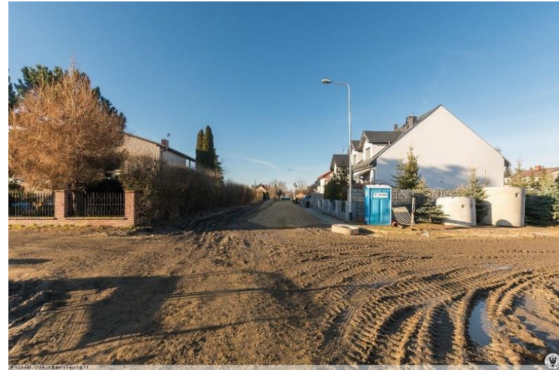
Fot. 23 - Przebudowa ul. gen. Władysława Andersa oraz ul. Brzozowej w Strzegomiu
